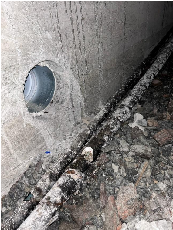
Bilde 15: Prøve B7 svart rørpapp
