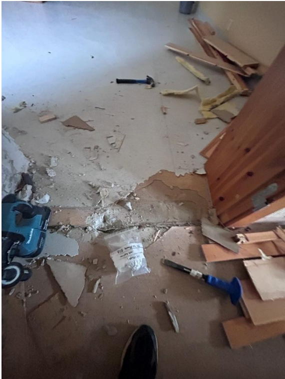
Bilde 37: Prøve B2B – betong med avretting gulv. Farlig avfall på grunn av PCB.
