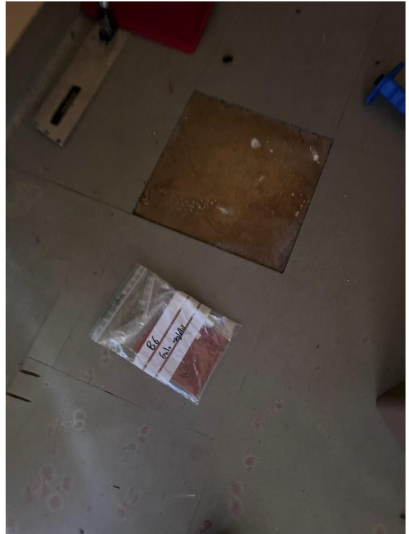
Bilde 32: Gulvflis av vinyl. Farlig avfall med ftalater. Ikke påvist asbest.
