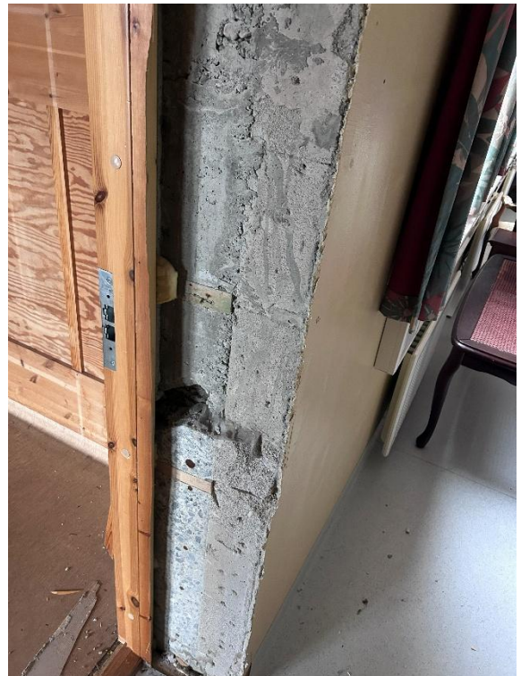
Bilde 40: Viser siporex på innervegg
