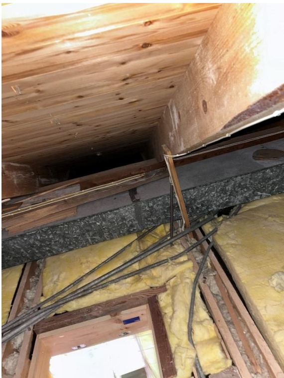
Bilde 17: Grå fuge på ventilasjon prøve B10
