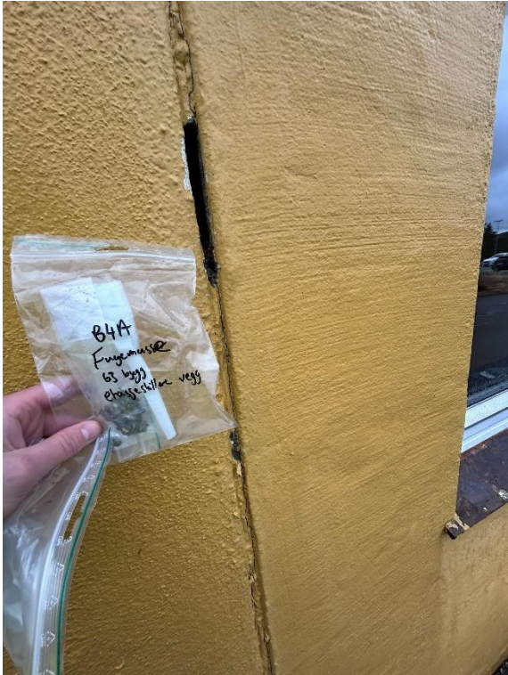
Bilde 1: Fugemasse brannskillere – påvist asbest
