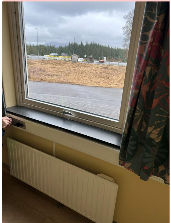
Bilde 4: Vindusposter av skiferstein som er antatt innhold av asbest.
