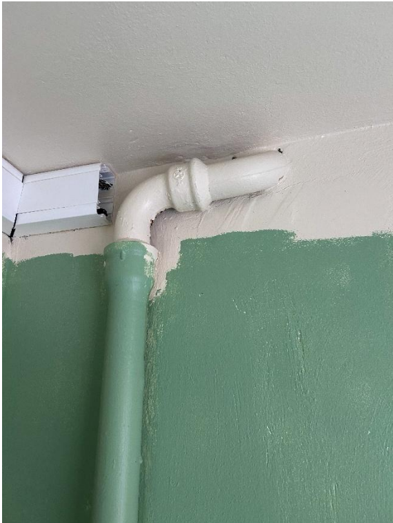
Bilde 5: Antatt asbestpakning under blyskjøl i soilskjøter
